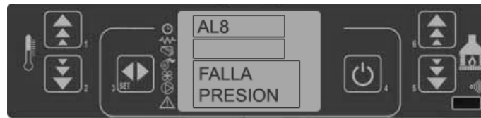
48. panel de mandos - alarma presostato de seguridad del tornillo sin fin
